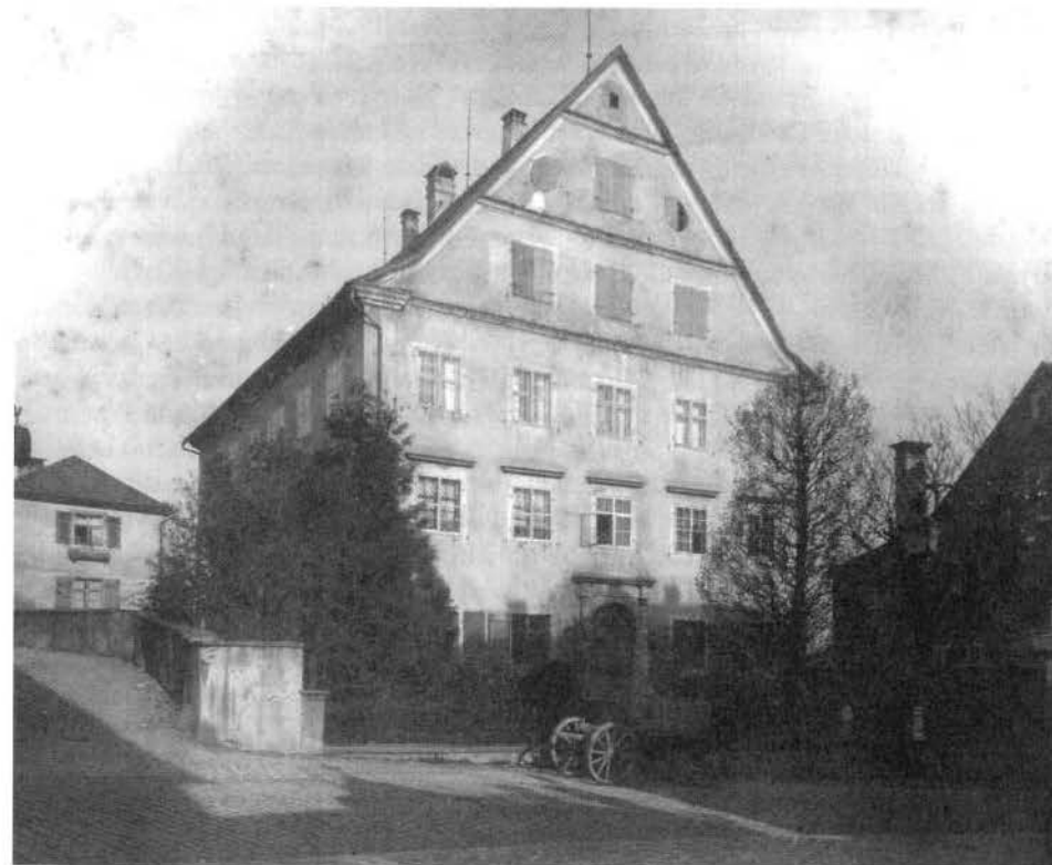
1904–1920 übersiedelte das Landesarchiv schrittweise von der »Seekaserne« ins »Alte Landhaus« in der Kirchstraße, hier kurz vor der Renovierung und Erweiterung 1912/13
