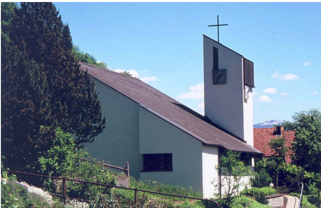
Wallfahrtskirche Mariä Heimsuchung in Freienbach
