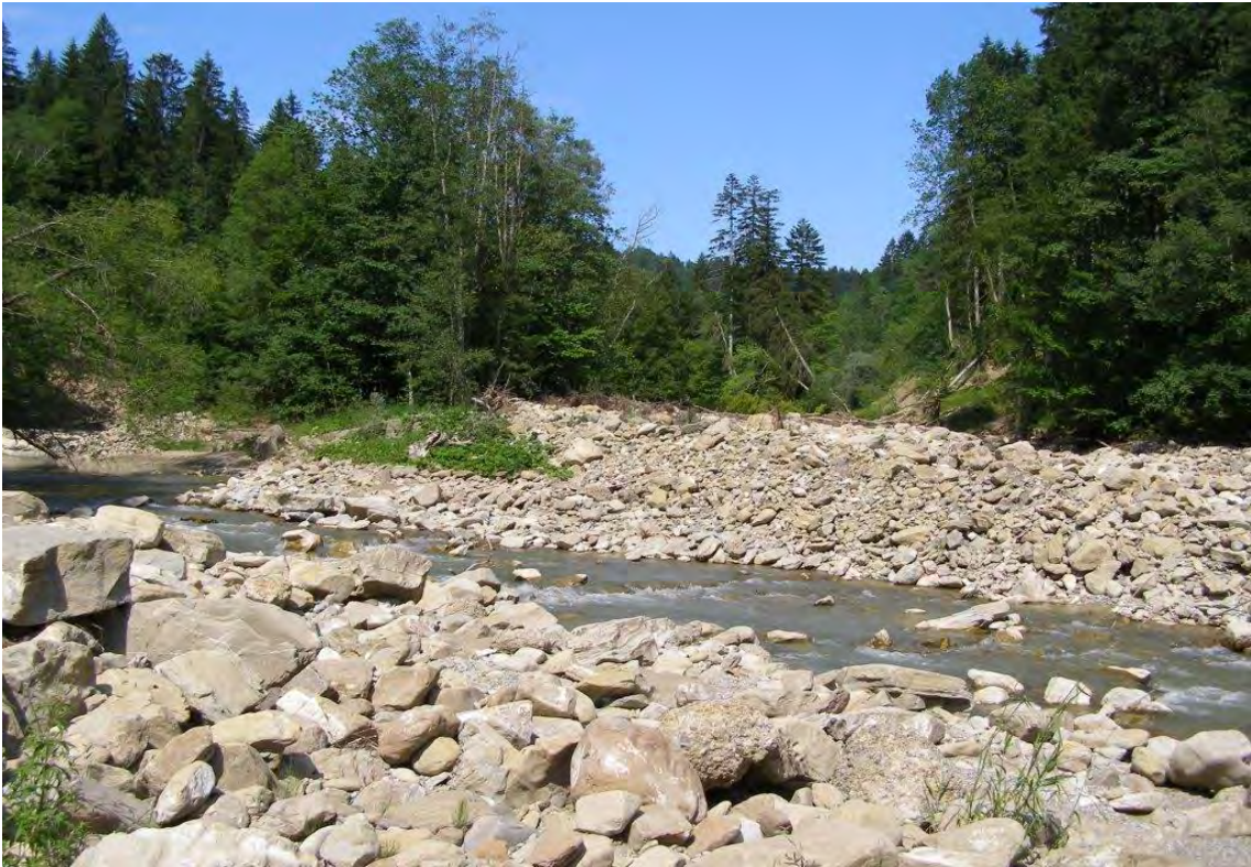
Blick auf die Weissach an der Gemeindegrenze Richtung Nordosten ins Gemeindegebiet von Doren und Krumbach.
